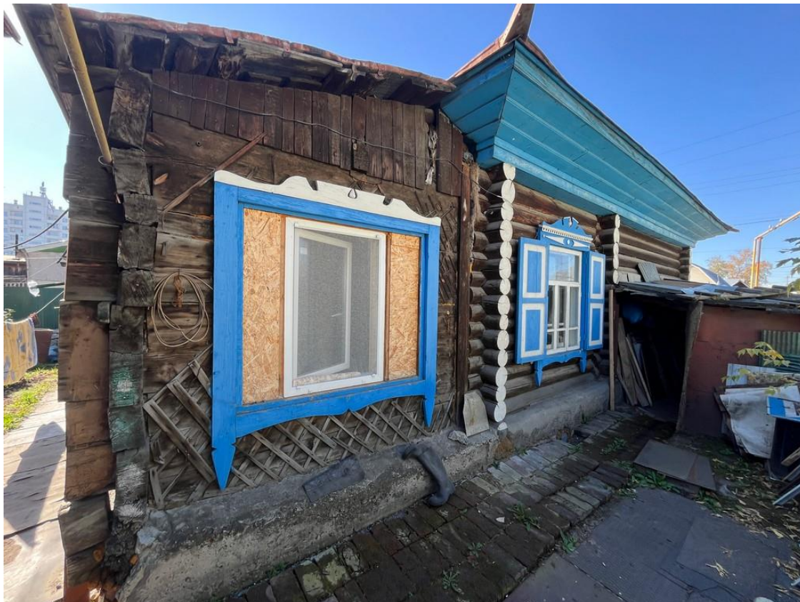
Фото 3. Фасад дома по оси В
