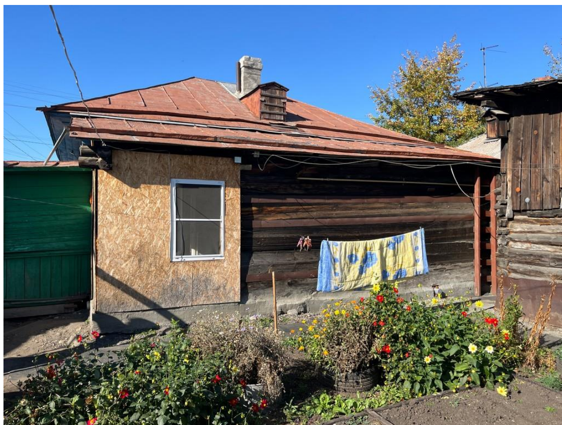
Фото 4. Фасад дома по оси 4
