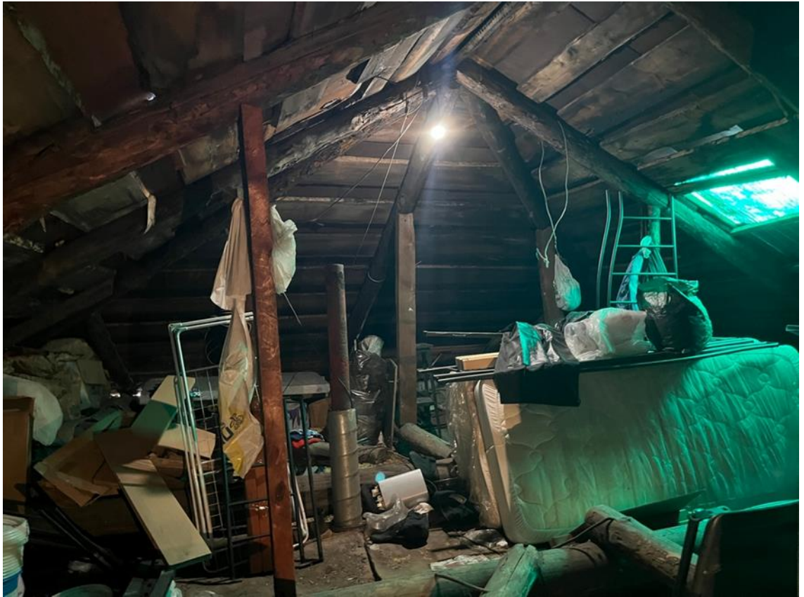
Фото 13. Общий вид стропильной системы
