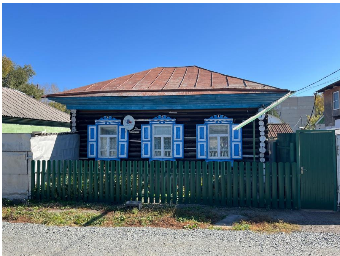
Фото 2. Фасад дома по оси 1
